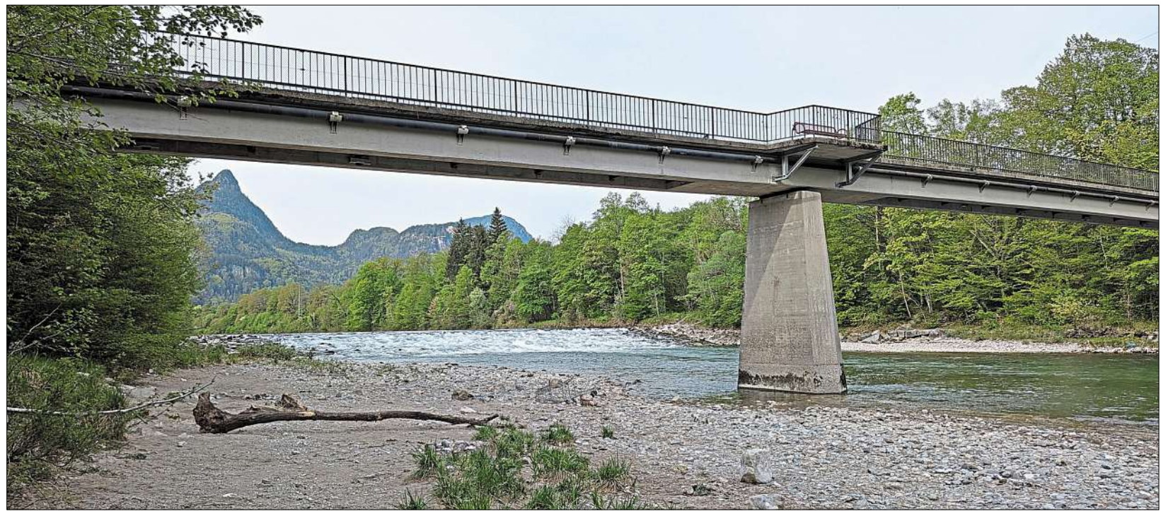
Neu gestaltet werden soll der Bereich der Saalach auf Höhe der Nonner Rampe. Neben dem Wasserkraftwerk soll auch der Steg umgebaut werden. – Foto: Max Klapper
