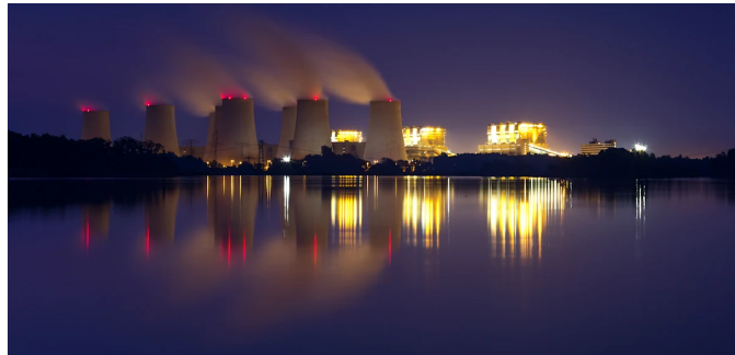
Kraftwerk in Jänschwalde, Brandenburg
